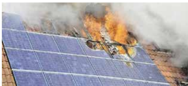
Şekil 9. Çatılarda PV paneller ve yarattığı yangın riski [8]
