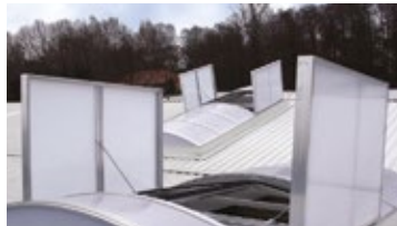
DUMAN TAHLİYE - HAVALANDIRMA AYDINLATMA SİSTEMLERİ
