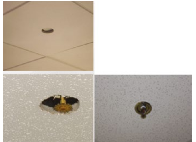
Şekil 1. Doğru püskürtme kafası pozisyonlamasına kıyasla hatalı püskürtme kafası pozisyonlaması
