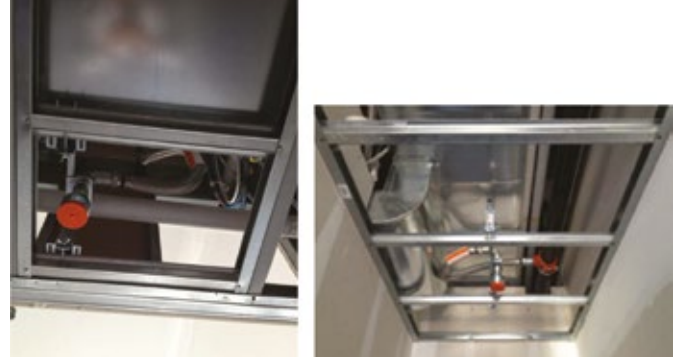
Şekil 6. Kalabalık ortamlara yerleştirilen esnek düşümler
